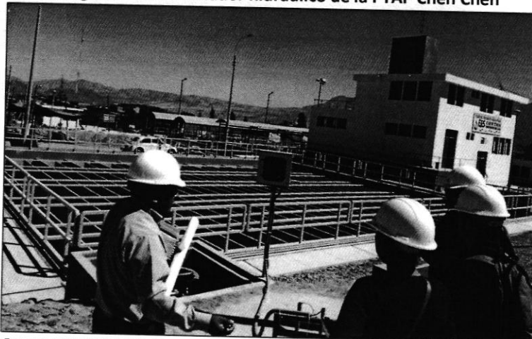
Imagen N° 14: Floculador hidráulico de la PTAP Chen Chen
