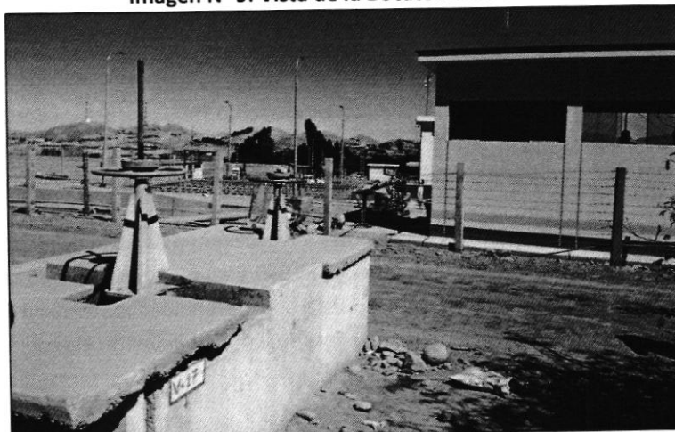
Imagen N° 9: Vista de la Bocatoma de Chen Chen
