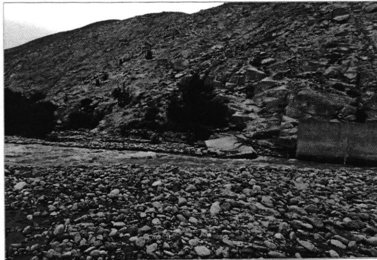
Imagen N° 30: Vista de la línea de conducción Ollería colapsada
