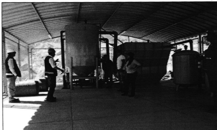
Imagen N° 24: Vista de las unidades de tratamiento de la PTAP C.P. Los Ángeles
