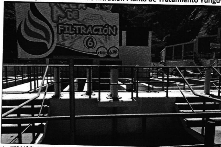
Imagen N° 21: Área de filtración Planta de Tratamiento Yunguyo
