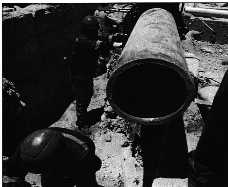
Imagen N° 38: Vista de la nueva línea de conducción Yunguyo
