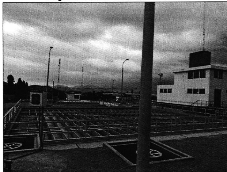
Imagen N° 42: Vista de la PTAP "Chen Chen"
