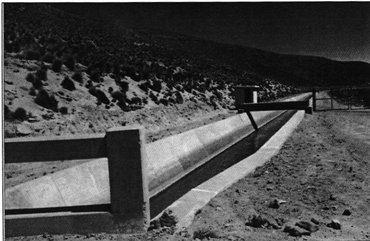
Imagen N° 8: Canal proveniente de la presa Pasto Grande hacia la PTAP Chen Chen
