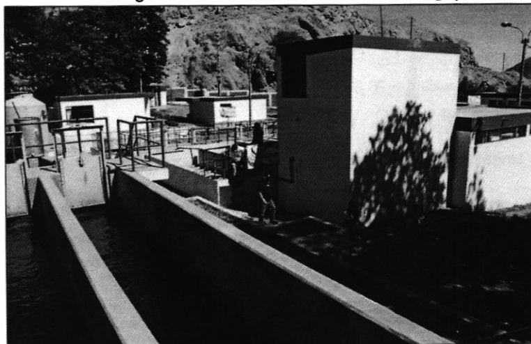
Imagen N° 15: Desarenadores de PTAP Yunguyo
