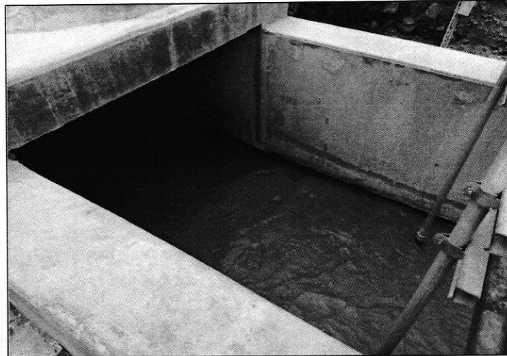
Imagen N° 41: Calidad de agua cruda proveniente de presa Pasto Grande
