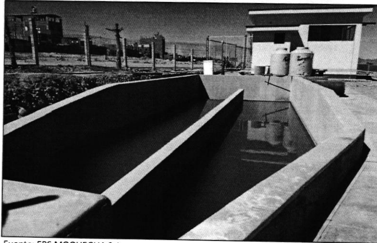
Imagen N° 13: Desarenadores de la Planta Chen Chen
