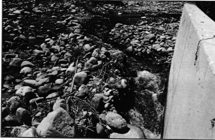
Imagen N° 10: Vista de la captación de Yunguyo
