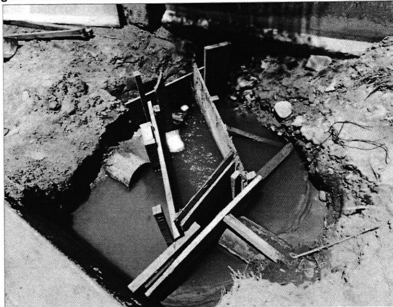
Imagen N° 37: Vista de la conexión artesanal de línea de conducción Yunguyo
